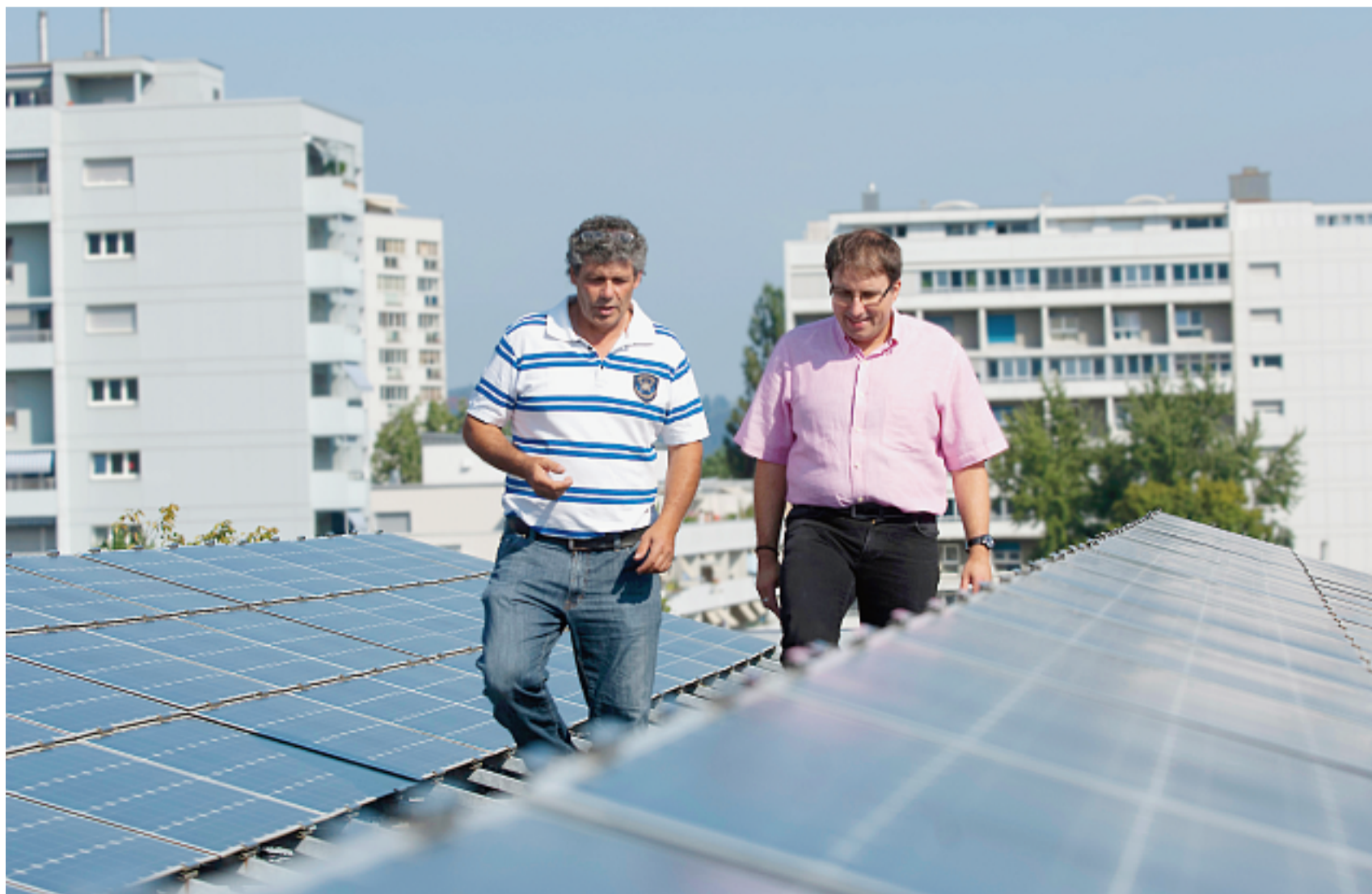
Der EVP Nidau sind Energiethemen wichtig. Auf dem Dach des Weidteileschulhauses inmitten der Photovoltaik-Anlage beginnt der Spaziergang mit dem BT. Peter Lehmann (links) und Philippe Messerli sind die beiden aktuellen EVP-Stadträte in Nidau. Peter Samuel Jaggi
